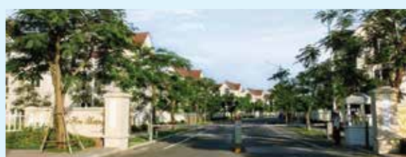
Dự án: VINHOMES RIVERSIDE của tập đoàn VINGROUP Project: Vinhomes Riverside urban area
