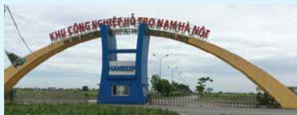
Dự án: Khu công nghiệp hỗ trợ Nam Hà Nội (HANSSIP) Project: HaNoi Southern Supporting Industrial Park (HANSSIP)
